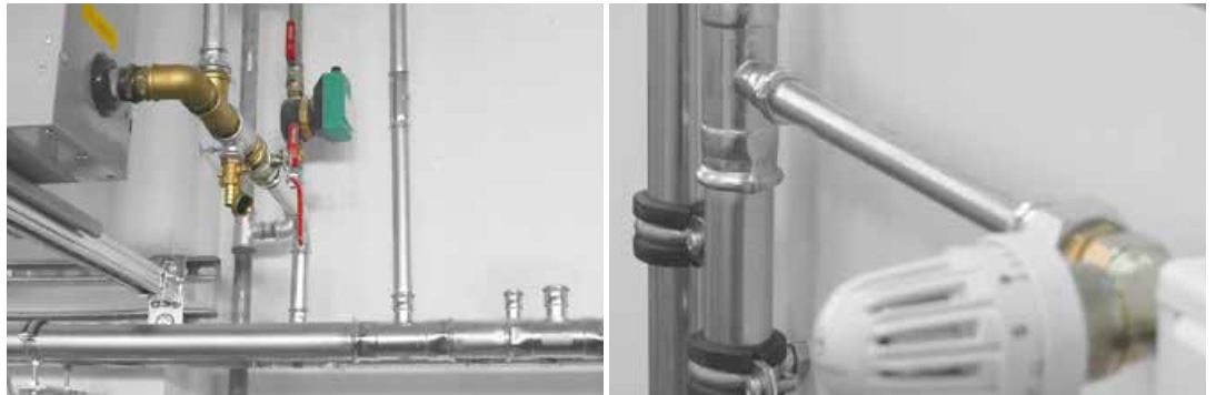
Primeri KAN-therm Steel instalacija
