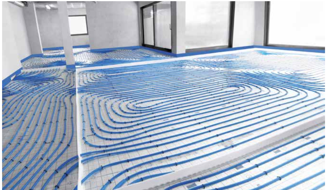
Slika 25. KAN-therm Tacker sistem podnog grejanja/hlađenja.
