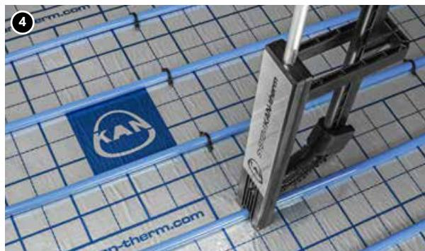
3. Treba položiti naredne trake na izolaciju, izlažući izbočene jezičke folije na susednim pločama. Susedne izolacione trake moraju biti konzistentne sa linijama rešetke. Tačke za kontakt svih ivica moraju biti zaptivene samolepljivom trakom dok polaganje narednih traka napreduje.
