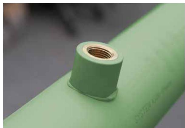
Moguća konfiguracija povezivanja KAN-therm PERT  $18\text{ mm} \times 2\text{ mm}$  cevi sa KAN-therm stabiGLASS PPR kolektorom izvedenim od cevi prečnika 50 mm:
