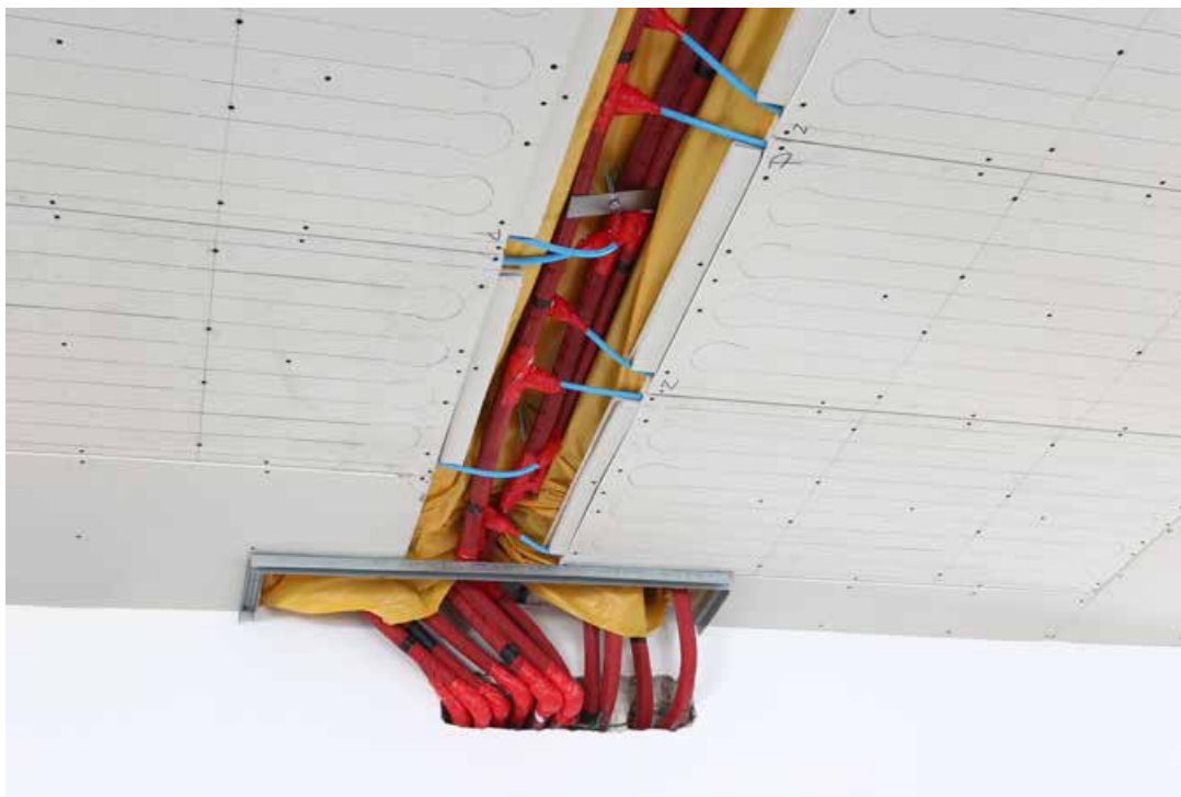
Slika 6. Instalacija plafonskog hlađenja pomoću panela za grejanje i hlađenje KAN-therm Wall sistema.
