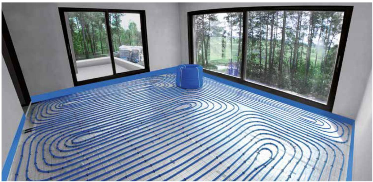
**Slika 3.** Instalacija podnog grejanja u jednoj porodičnoj zgradbi, korišćenjem bluePERT cevi i KAN-therm Tacker sistema.
