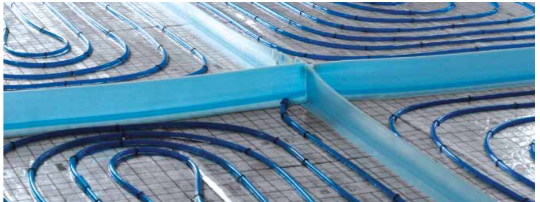
Slika 14. Raspored grejnih polja sa dilatacionim pregradama
