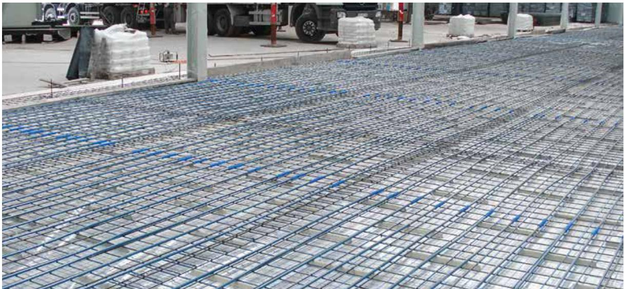
**Slika 4.** Instalacija podnog grejanja u industrijskom objektu, korišćenjem bluePERT cevi i KAN-therm NET sistema.
