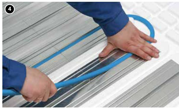
3. Postavite čelične lamele (radijatore) u kanale na ploči, odvojene jedna od druge 5 mm. Lamele imaju poprečne ureze (svakih 250 mm) koje omogućuju podešavanje njihove dužine i usklađivanje sa dužinom postavljenih ploča. Lamele postavite tako da se poprečna ivica završava približno 50 mm od promene smera cevi.
